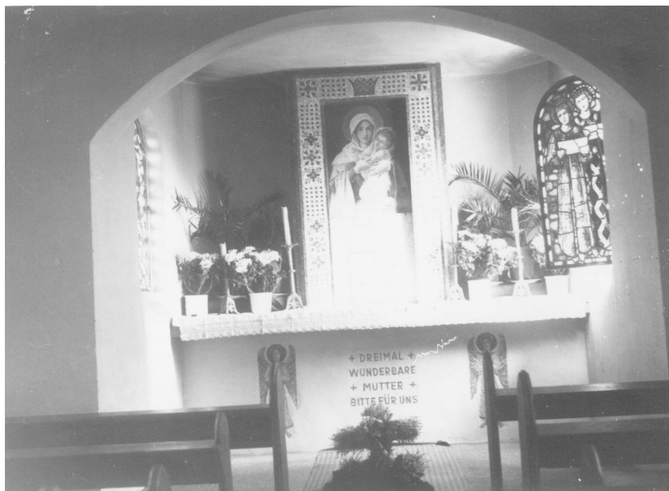
Glasfenster im Altarraum mit zwei Engeln. Foto vom November 1942
