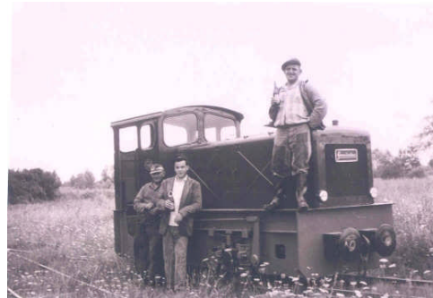
Diesellok der Ziegelei Merkel
