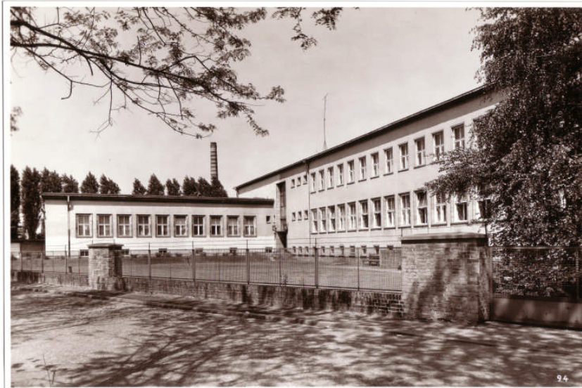
[40] Verwaltungsgebäude, Entwicklung, HF-Fertigung
