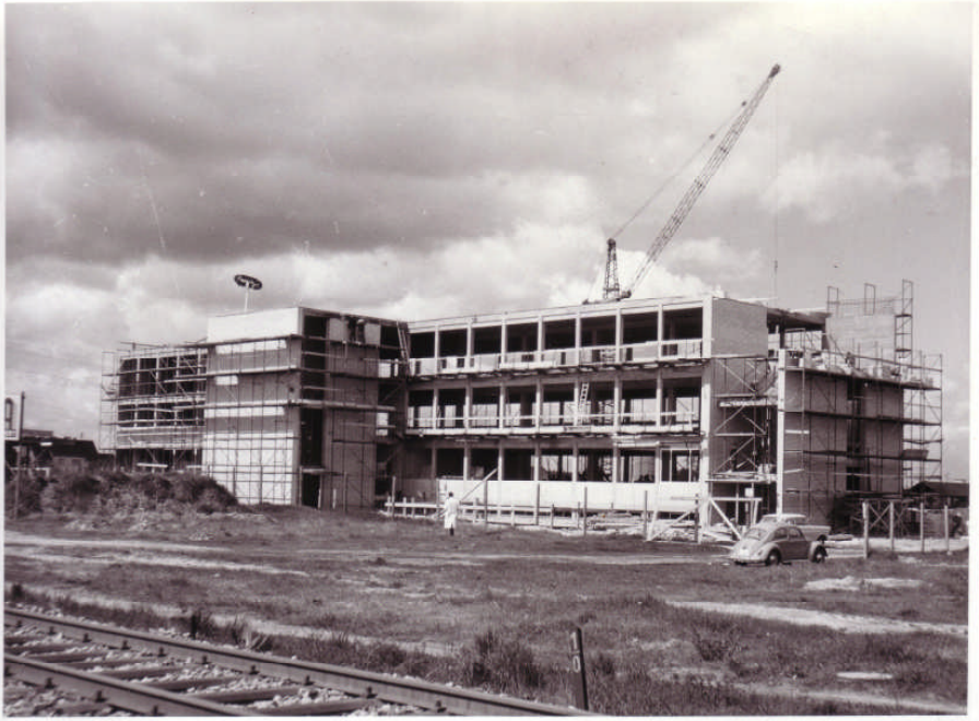
[51] Rohbau des Görler- Werkes 1962, Im Vordergrund die ehem. Eisenbahnstrecke Rheinau – Brühl - Ketsch
