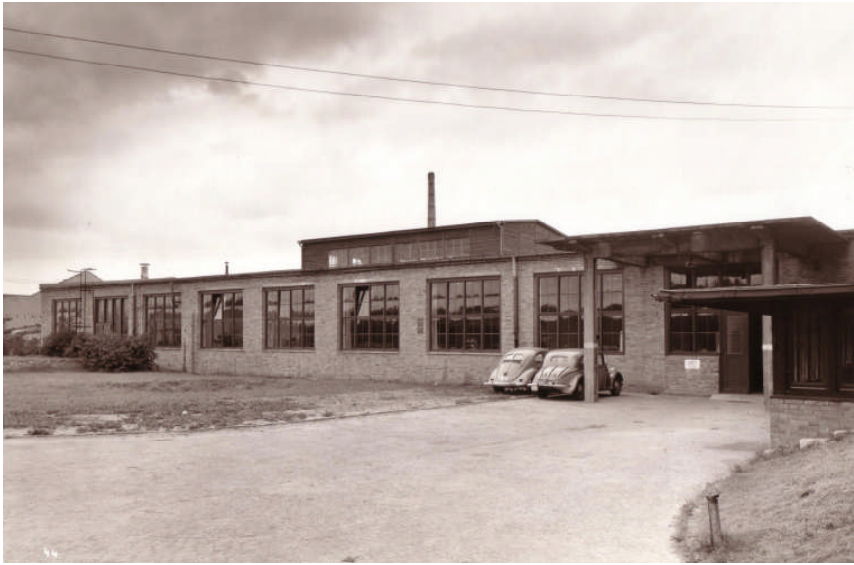
[41] Halle 1: Trafowickelei, Trockenanlage, Kleintransformatorenbau Foto:G.Gritschke
