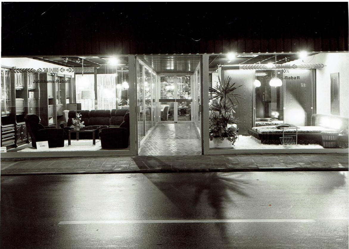
Der neue Eingang (Straßenfront) nach dem Umbau.
