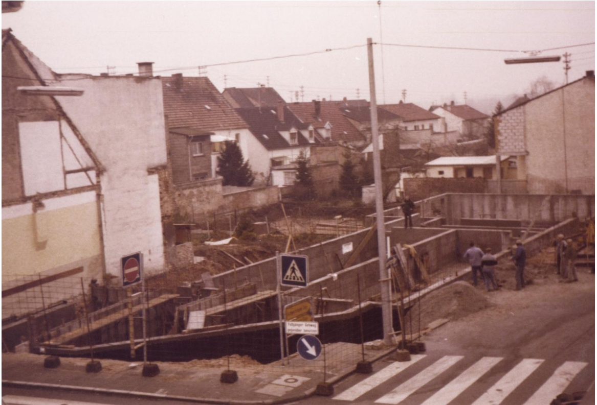
Dann bei der Anlage der Grundmauern ...
