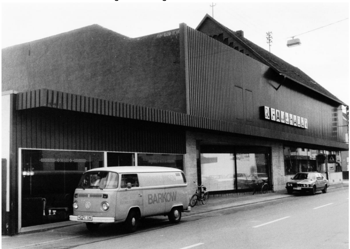
Die Front des Kaufhauses Mannheimer Straße 42 in den 1960er/70er Jahren.
