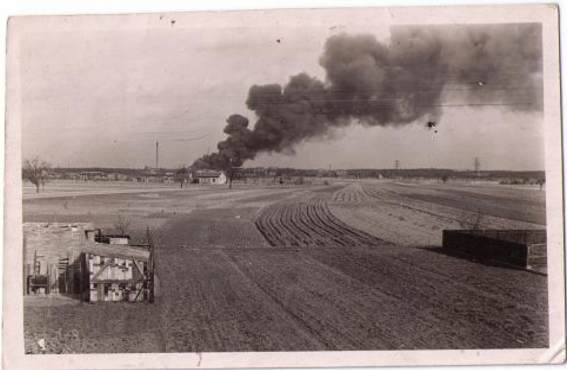
Schütte-Lanz Holzwerke am 1. März 1945: Rauchsäule über dem Betriebsgelände.
