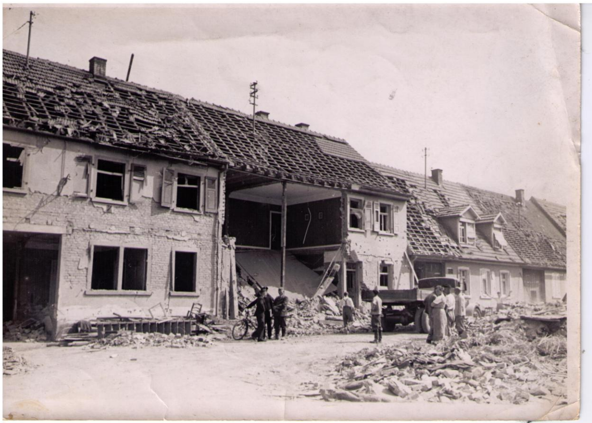
Aufräumarbeiten in der Görngasse 5 und 7.
