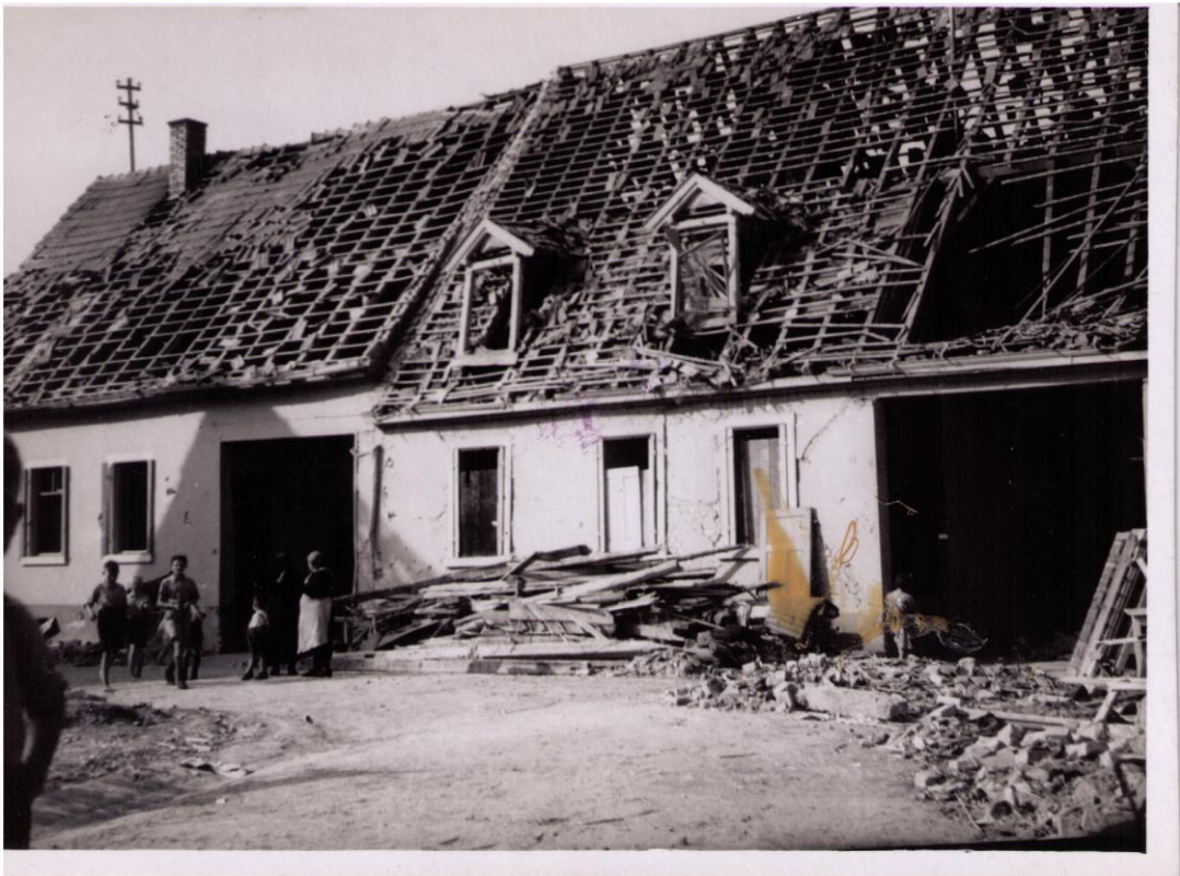
Die Häuser in der Görngasse 1 und 3 – vom Luftdruck der gegenüber eingeschlagenen Bombe schwer beschädigt.
