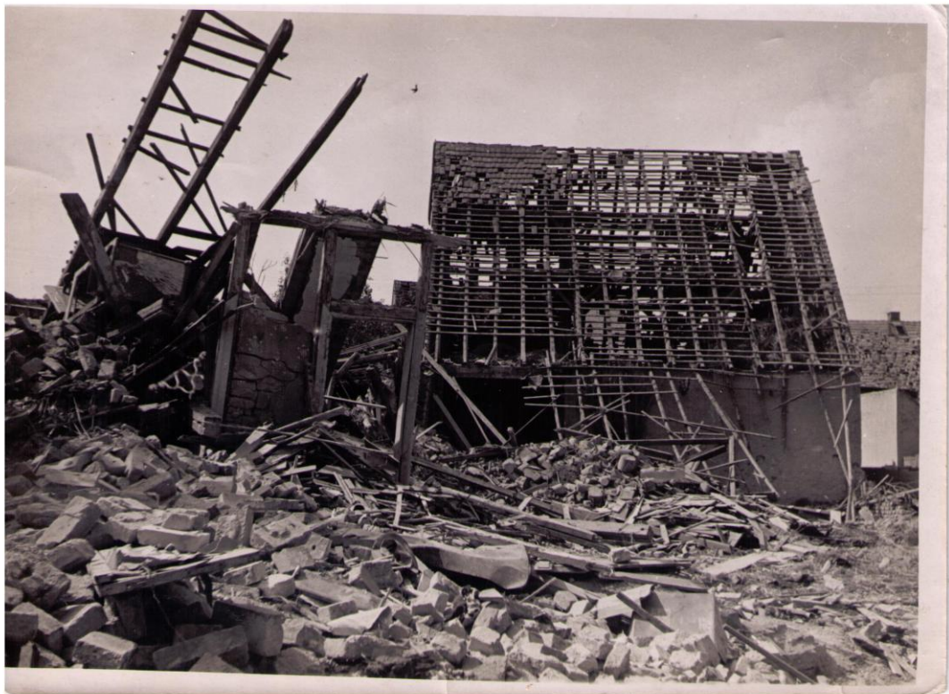
Die Trümmer des Hauses Görngasse 2.
