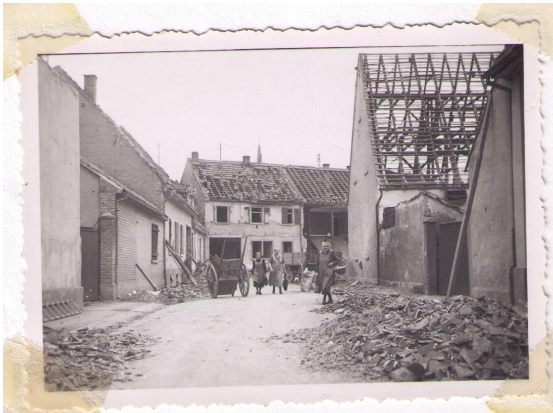
Blick auf die Görngasse 5, vorne rechts das Gasthaus Krone. Das Dach der Scheune wurde durch den Luftdruck völlig abgedeckt.
